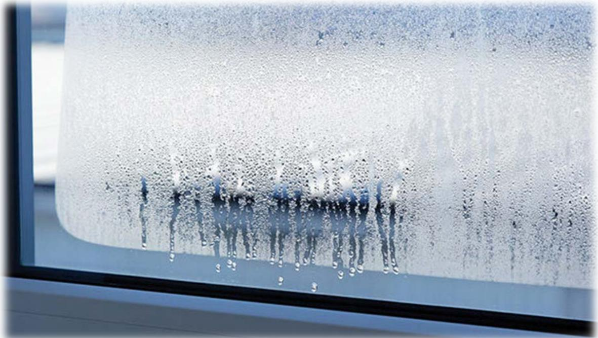
Schwitzwasserbildung im Randbereich von Isoliergläsern kommt sowohl bei Neubauten als auch bei Sanierungen häufig vor. Mangelnde Luftkonvektion, Vorhänge, tiefe Fensterlaibungen, Pflanzen und tiefe Vorlauftemperaturen bei Bodenheizungen begünstigen die Kondensatbildung. Regelmässiges Stosslüften fördert die Luftkonvektion und reduziert die Feuchtigkeit in der Raumluft.
